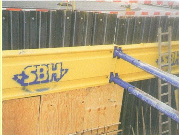
Die Anwendung ist auch bei engen räumlichen Gegebenheiten denkbar einfach: Der vor Kopf stehende Bagger senkt die Kanaldielen mit dem Baggerlöffel dem Aushub folgend ab. Alternativ kann das Absenken auch durch Rammgeräte erfolgen.
