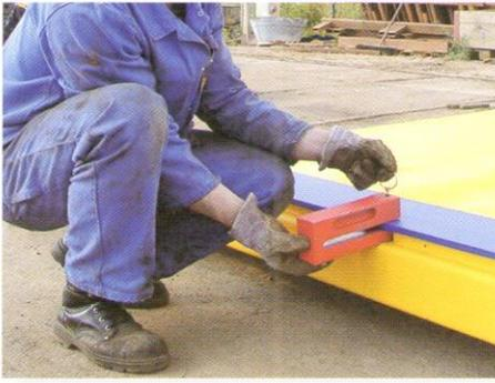
Die Verbauplatten mit den unteren Verriegelungen bestücken. Die Rollenschlitten aufsetzen, gegen die Verriegelung schieben und mit den oberen Verriegelungen sichern.
