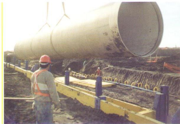
Der einzigartige Rollenschlitten lässt sich gegenüber den Gleitschienen parallel verschieben. Dadurch ist das Einbringen der Verbauwände mit geringem Kraftaufwand in großen Tiefen möglich.
